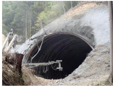
NATM工法（山岳工法）によりトンネル工事を行っています
