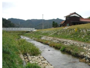
石と鋳鉄の根固工
