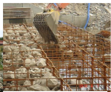
石と鋳鉄の根固工
